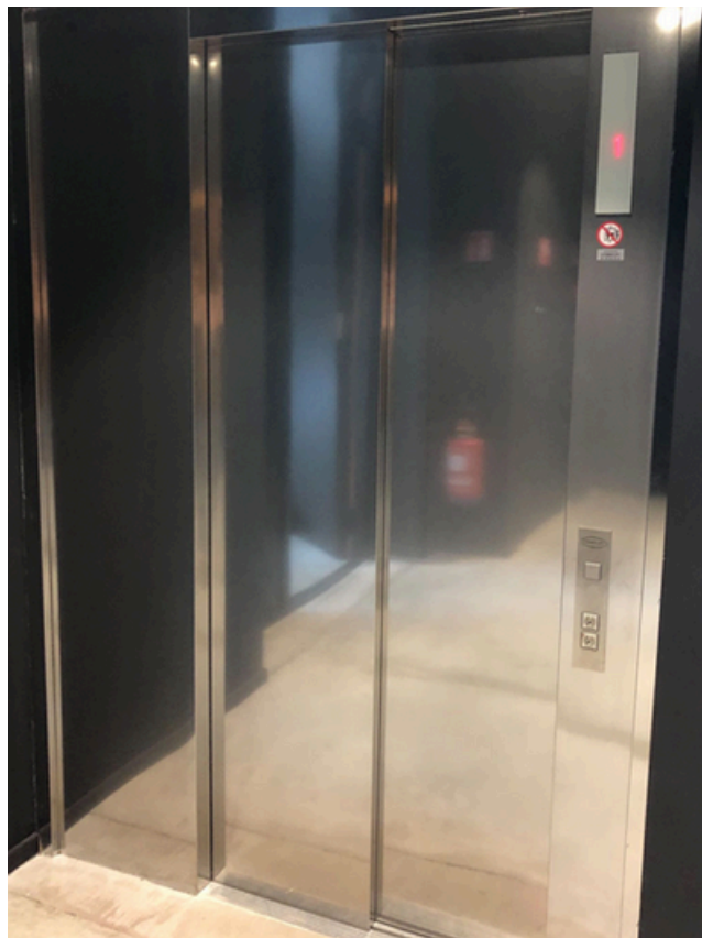
Lift naar 1ste verdieping
