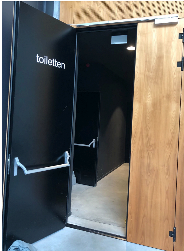
Deur naar toiletten (begane grond)
