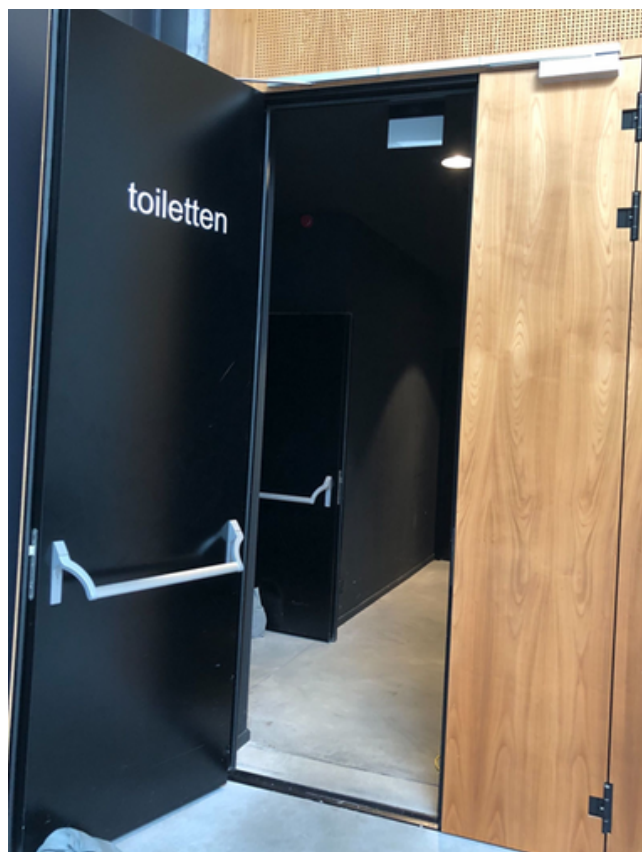
deur naar toiletten (begane grond)
